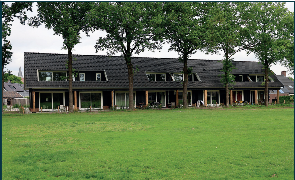
De 7 nieuwe appartementen die in 2025 op deze plek zijn gebouwd. De adressering is Grote Brink 3a-1 tot en met 3a-7.
