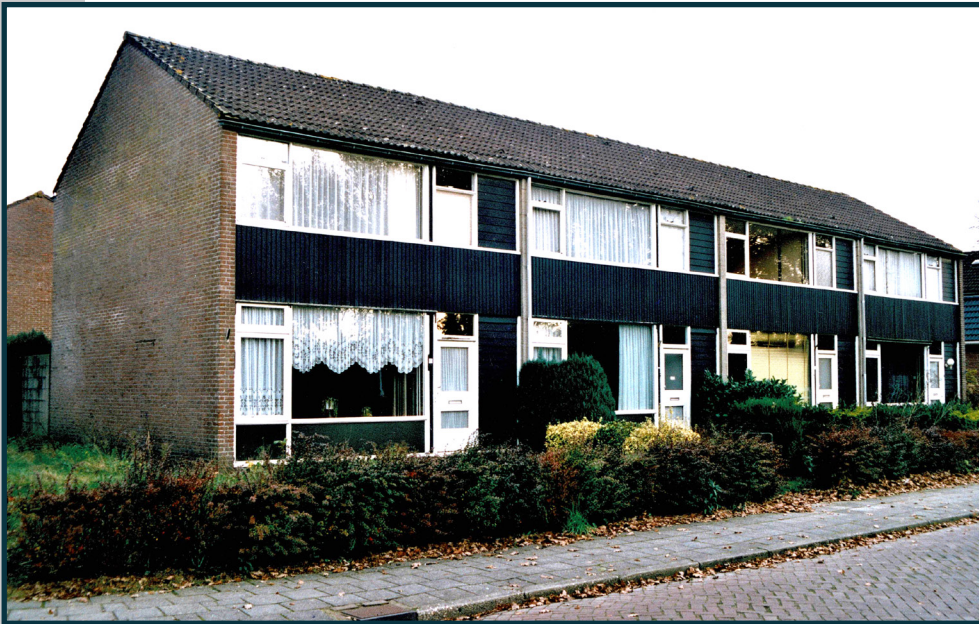
Deze HAKA woningen aan de Hoornsestraat 7 t/m 13 zijn in 1965 in opdracht van de voormalige gemeente Rolde gebouwd. In 2006 zijn ze gesloopt. (Foto Feije Takens, tekst Emmie Suichies)
